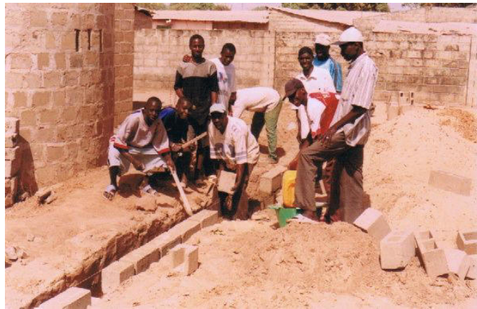
Das Fundament für die neue Mauer wird erstellt.
