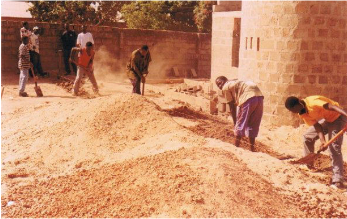
Ein Graben für das neue Fundament wird gebuddelt.
